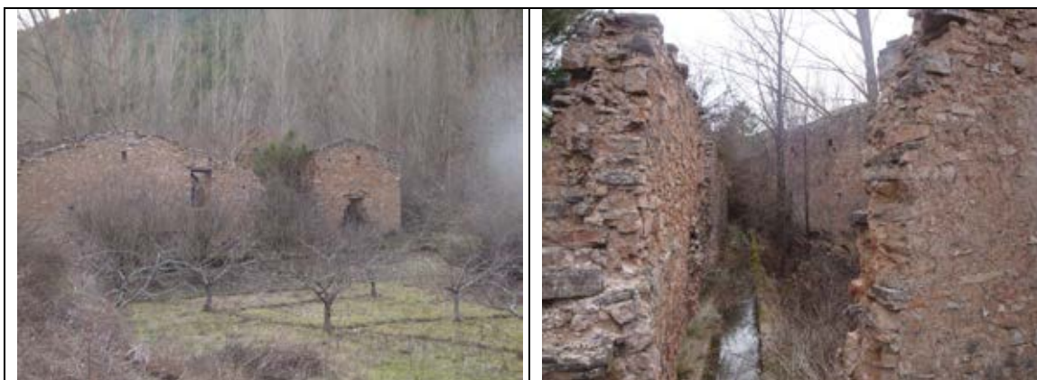
FOTOGRAFIAS 2 y 3. PARADA 2 Restos de la ferrería
