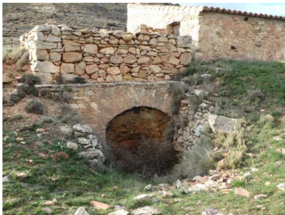
FOTOGRAFIA 3. PARADAS 3, 4 y 5 Parte frontal del tejero situado a la izquierda de la carretera
