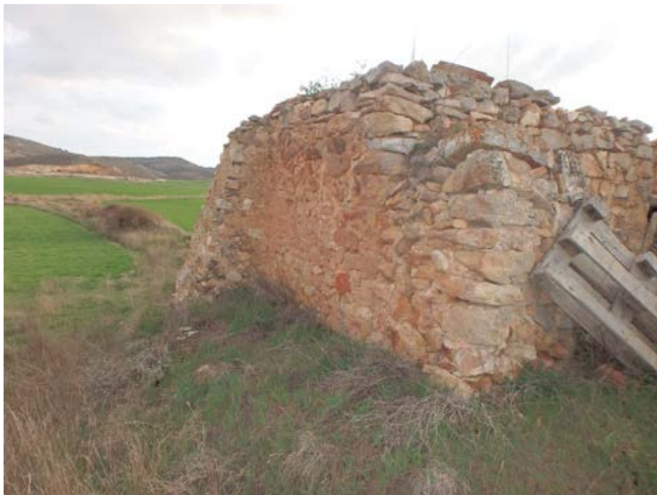
FOTOGRAFIA 9. PARADA 8 Restos del Tejar de Milmarcos
